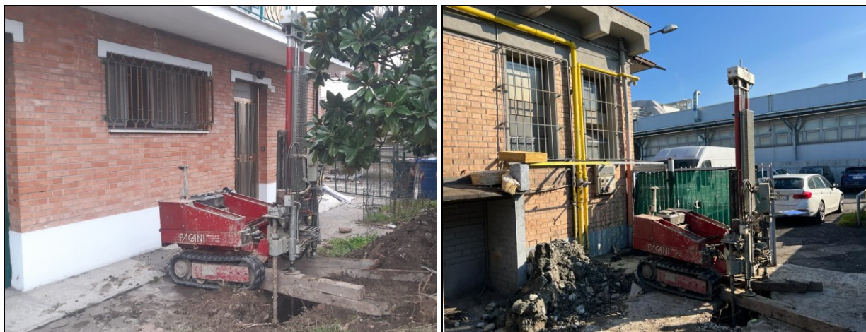
Figura 7c-d: immagini della prova penetrometrica CPT3 e CPT4
